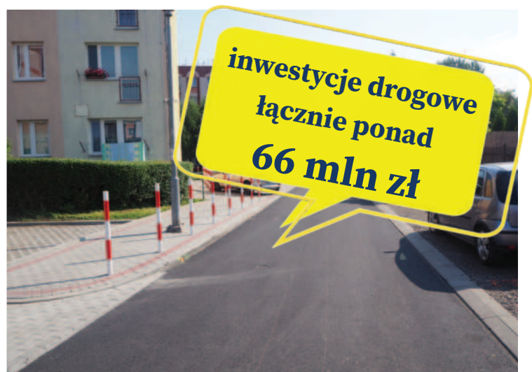
Dojazd do bloków ul. 3 Maja 44,46,48
